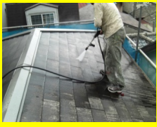
屋根 塗装 の下 準備 高圧 洗浄 中 です
